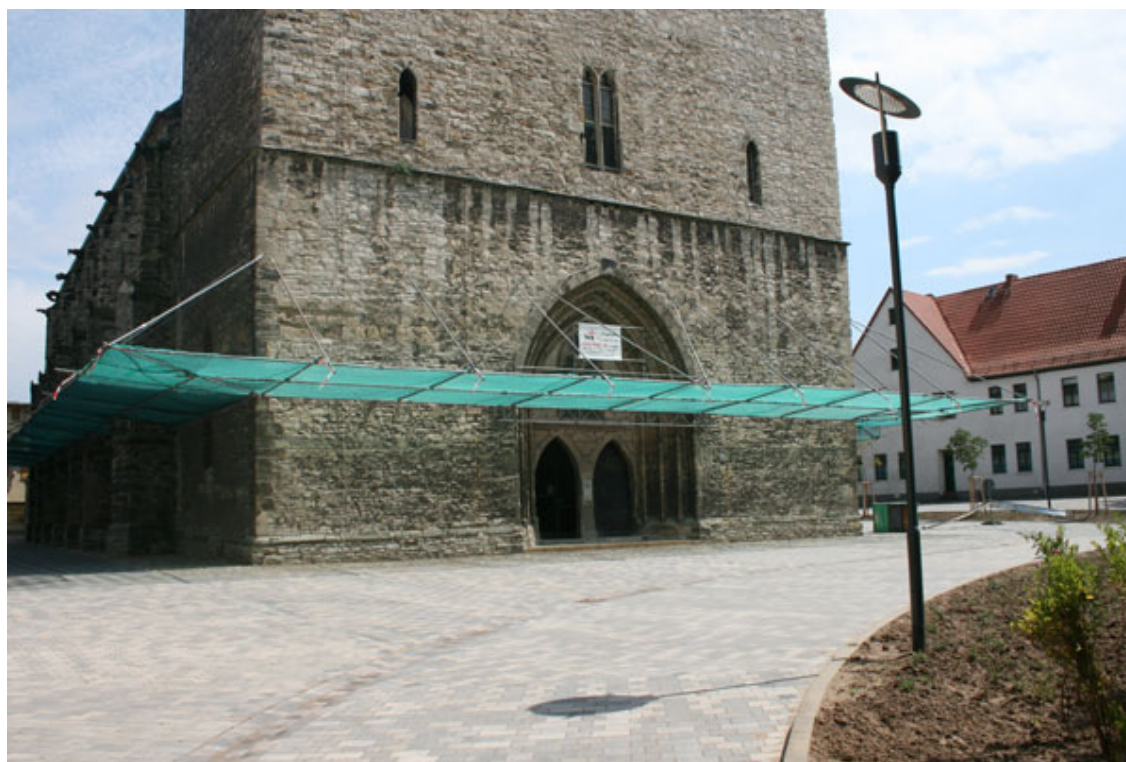
saniertes Kirchplatz in Calbe | Foto: L.Rode
